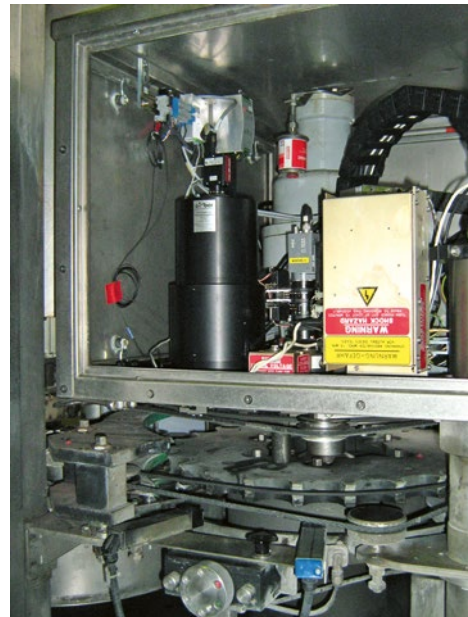
Einbausituation in bestehender Abfüllanlage
