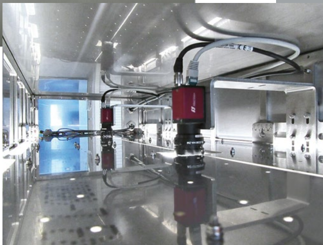
Blick ins Systeminnere mit Kameras und LED-Beleuchtung
